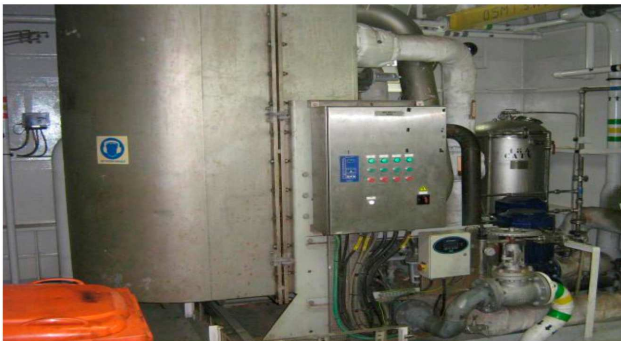
Figura 2 – Exemplo de destilador de dois estágios Alfa-Laval
