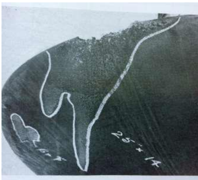
Figura 41: erosão por cavitação intensa causando perda de material
