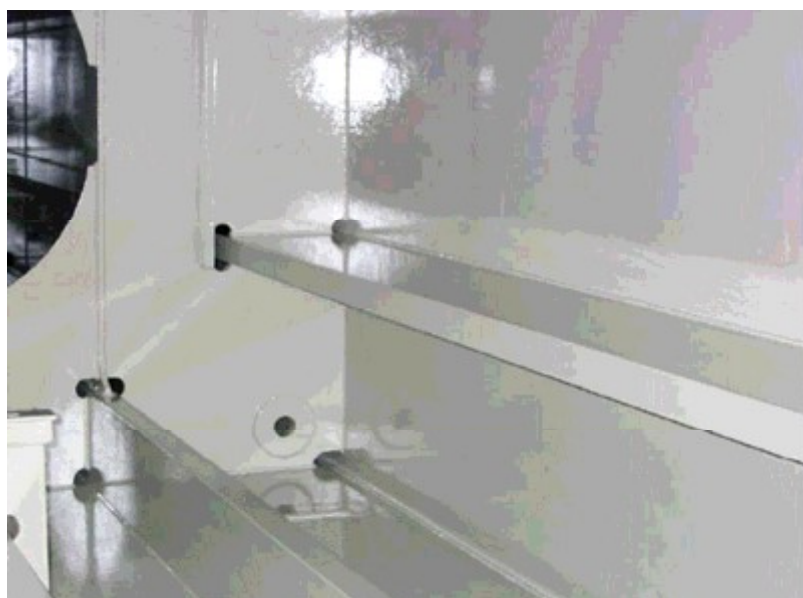
Figura 14 - Estrutura interna de um fundo duplo após o revestimento.
