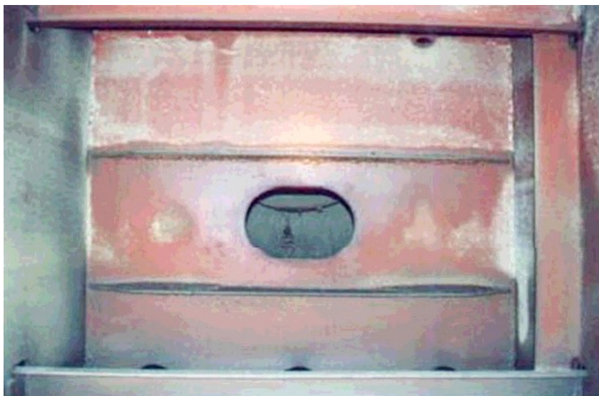
Figura 18 - Aplicação correta do revestimento, condição do tanque de lastro após 13 anos (um fundo duplo de graneleiro é mostrado nesse exemplo ).
