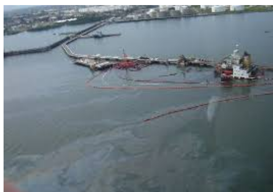
Figura 9 – No detalhe, uma das manchas produzidas pelo óleo que vazou
