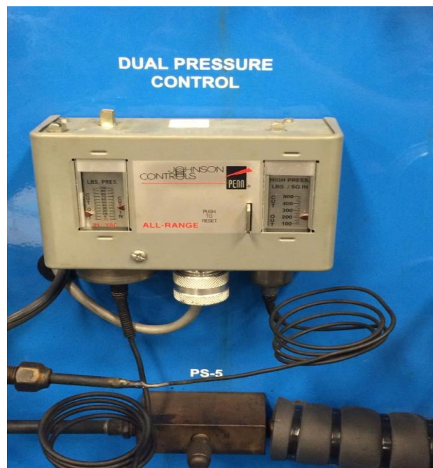
Figura 7: Pressostato de baixa pressão e alta pressão com botão de rearme manual.
