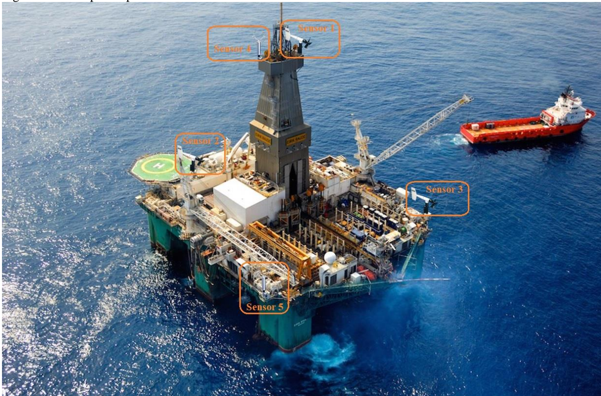
Figura 6 – Exemplo de posicionamento dos sensores de vento em unidades semissubmersíveis.
