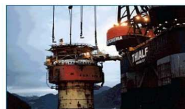
Nov 1998 - Topside pronto para içamento
