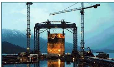
Mar 1999 - Casco pronto para içamento
