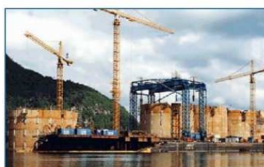
Jun 1999 - Limpeza concluída
