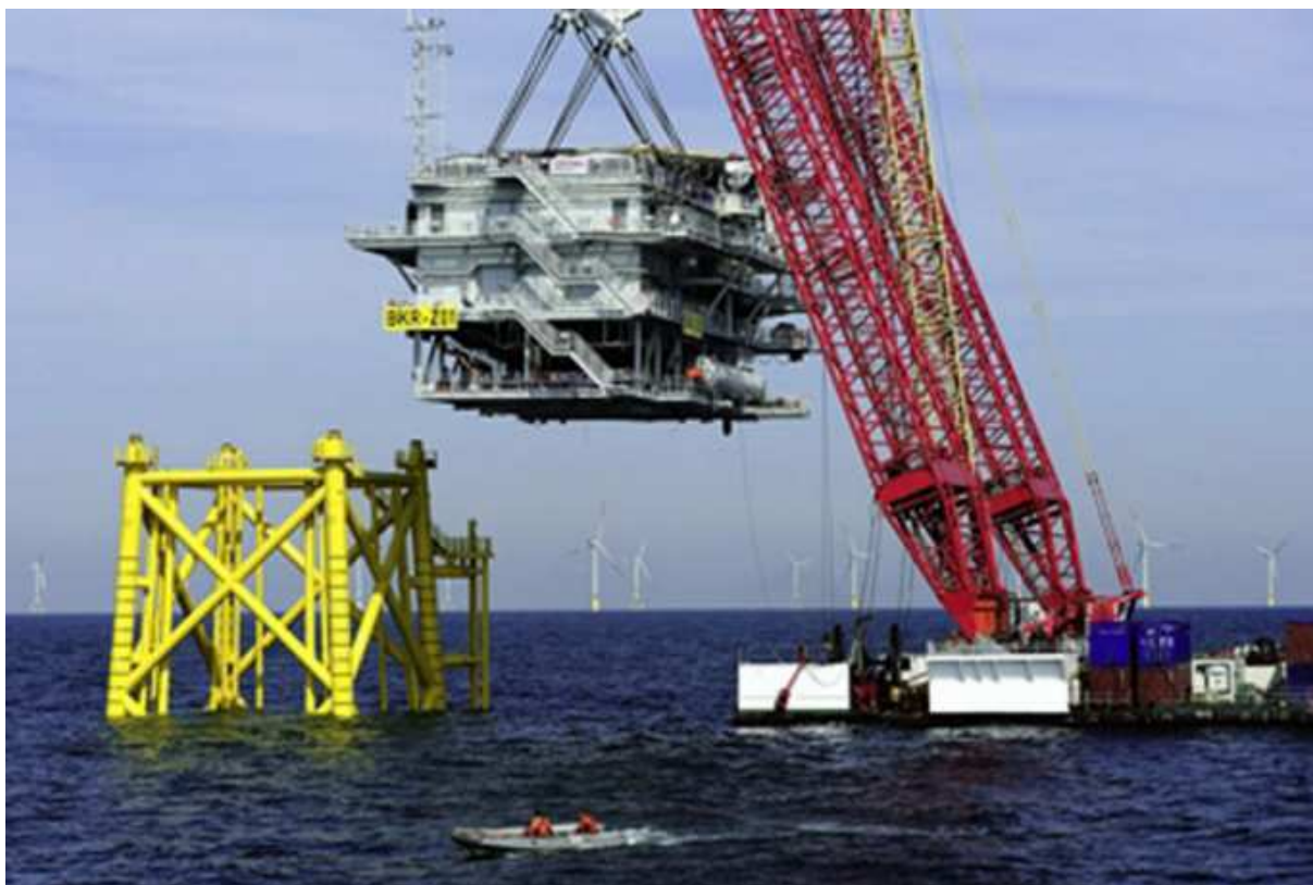
Figura 26: Içamento único de topside Fonte: Power Technology, 2013
