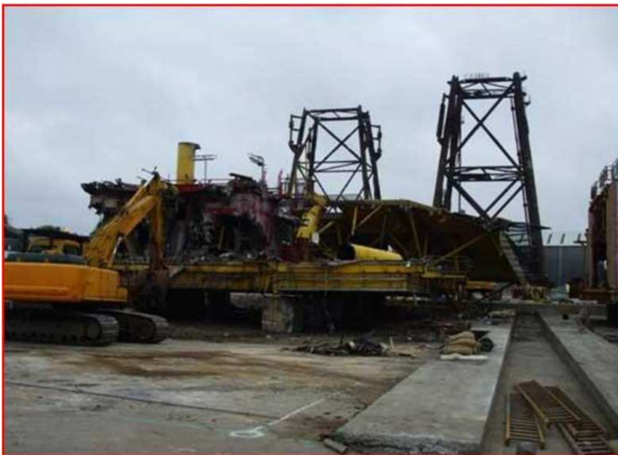
Figura 44: Indefatigable – desmonte final no estaleiro
