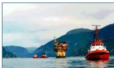
Ago 1998 - Sendo rebocada
