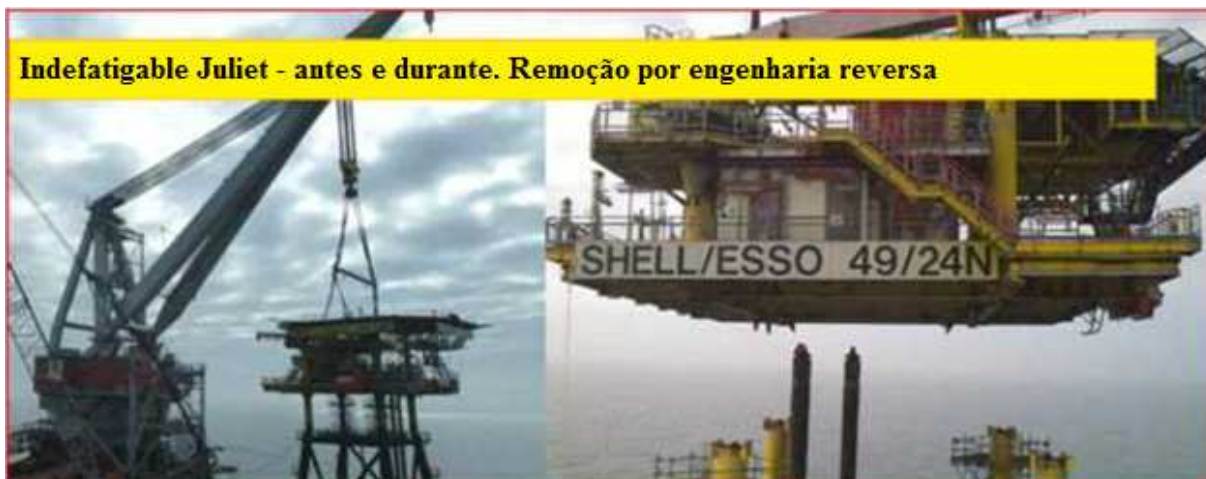
Figura 43: Indefatigable Juliet-P – remoção engenharia reversa Fonte: SHELL UK, 2014, p. 21 (tradução do autor)
