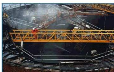
Jun 1999 - Limpeza dos tanques
