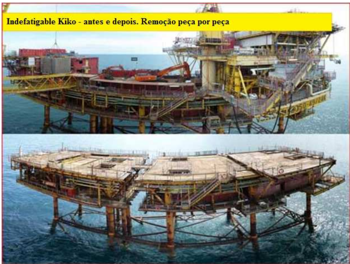
Figura 42: Indefatigable Kilo – remoção peça por peça Fonte: SHELL UK, 2014, p. 20 (tradução do autor)
