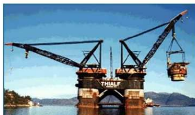
Nov 1998 - Topside içado
