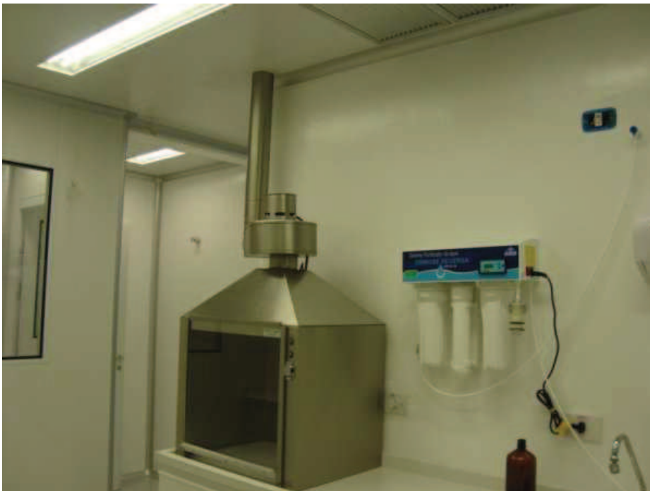
Figura 37: Exemplo de instalação de exaustores em laboratórios.
