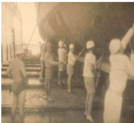
Ilustração 20 Raspagem de casco
