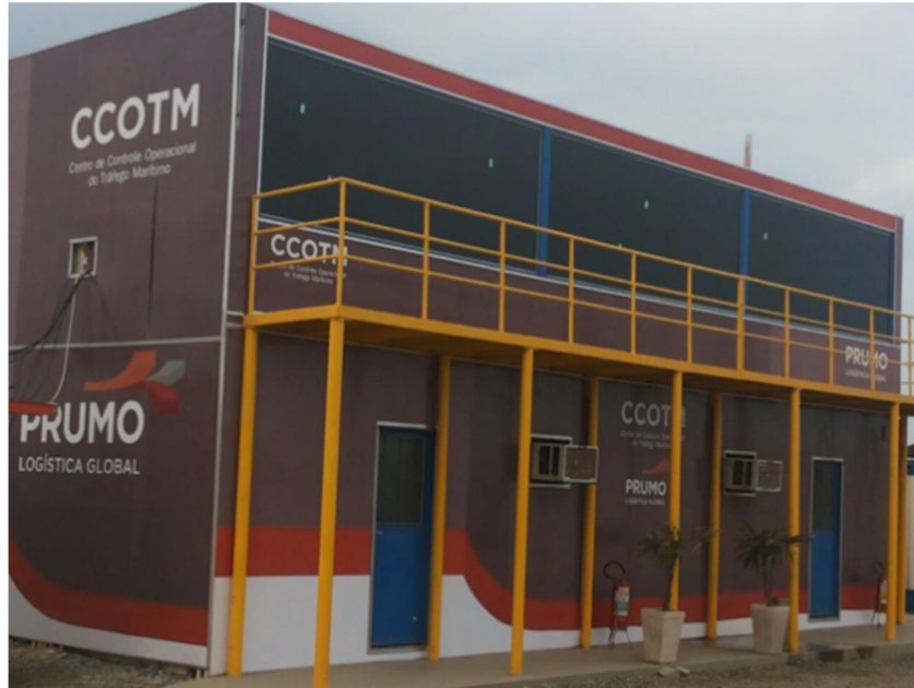
Figura 4 — Instalações de terra do VTS do Porto do Açu.
