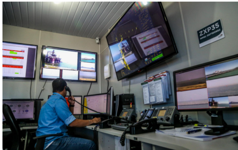
Figura 5 — Instalações de terra do VTS do Porto do Açu.
