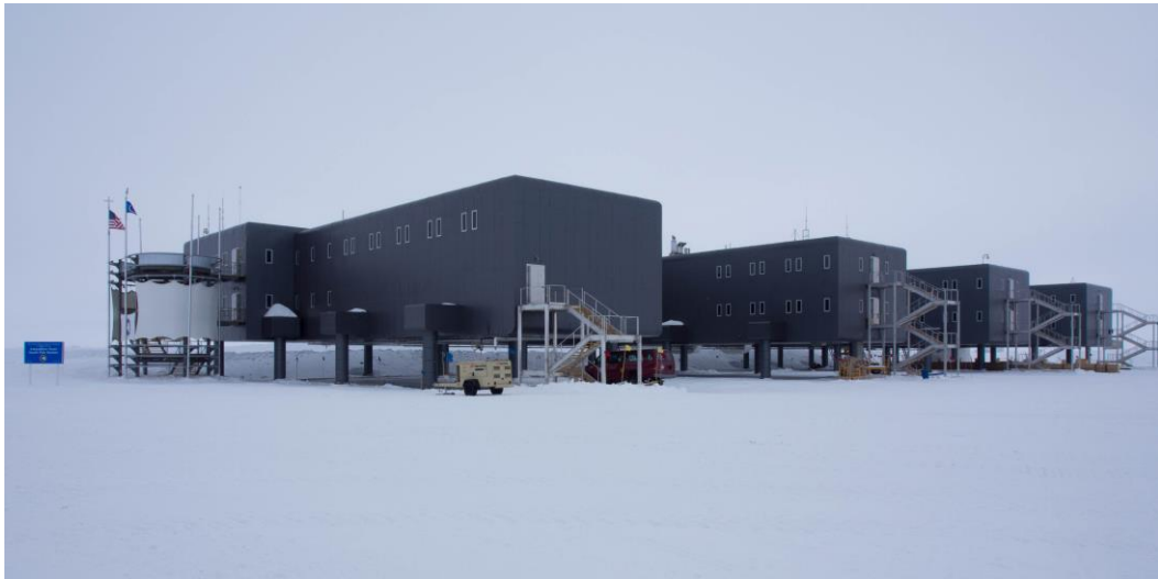
FIGURA 14 – Visão completa da Estação Amundsen-Scott
