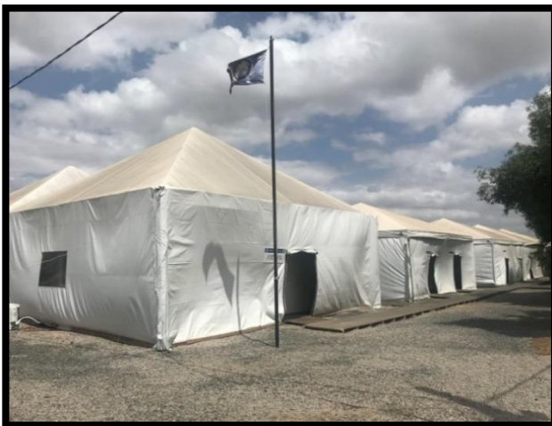
FIGURA 37 - Instalação semipermanente tipo Overlay Fonte: Operação Acolhida 2018.
