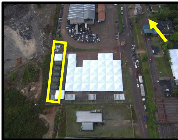
FIGURA 12 - Vista área do PAA Fonte: Operação Acolhida 2019.
