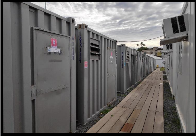
FIGURA 65 - Contêineres banheiros Fonte: Operação Acolhida 2018.
