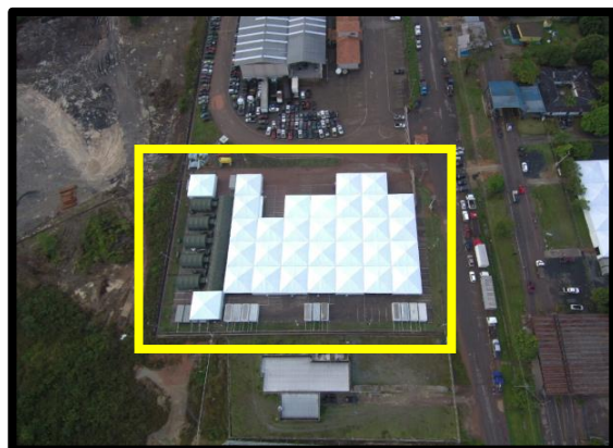
FIGURA 8 - Vista aérea do posto de triagem Fonte: Operação Acolhida 2019.
