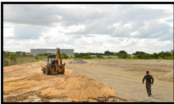
FIGURA 33 - Engenharia realizando terraplenagem Fonte: Operação Acolhida 2019.
