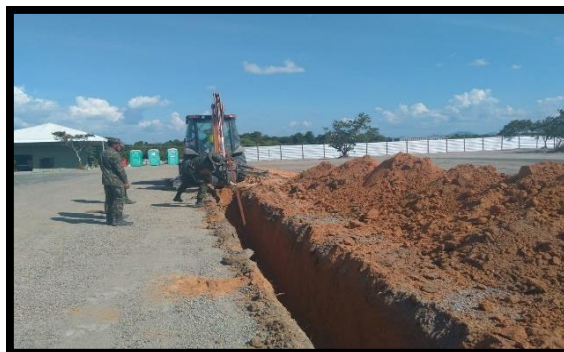
FIGURA 34 - Engenharia realizando dreno sanitário Fonte: Operação Acolhida 2019.
