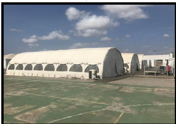
FIGURA 49 - Vista externa dos alojamentos de Cb/Sd Fonte: Operação Acolhida 2018.
