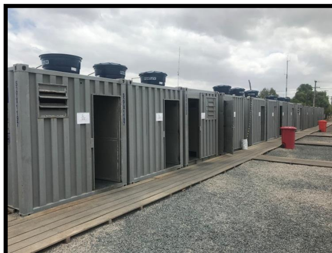
FIGURA 48 - Contêineres sanitários da área de Alojamento Fonte: Operação Acolhida 2018.
