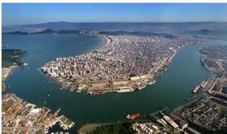
FIG 1 – Foto área do canal do Porto de Santos.
