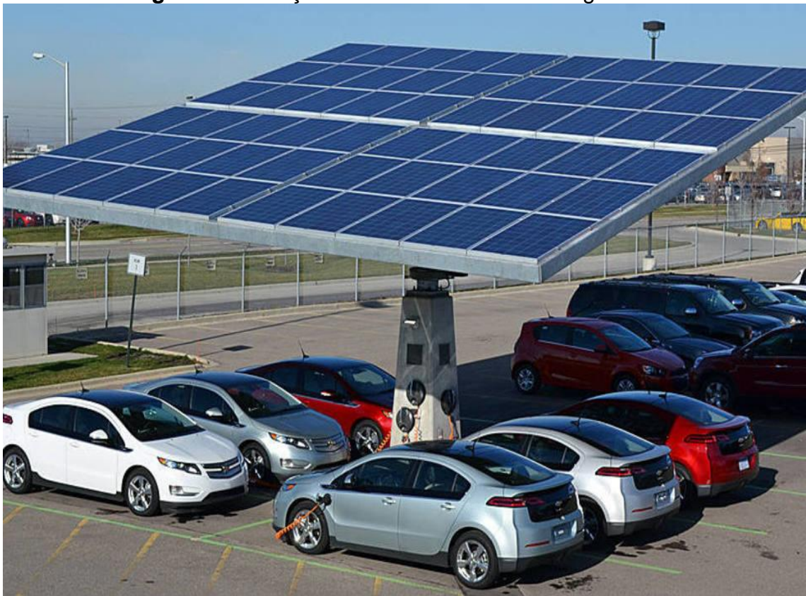
Figura 26: Estação de abastecimento a energia solar.
