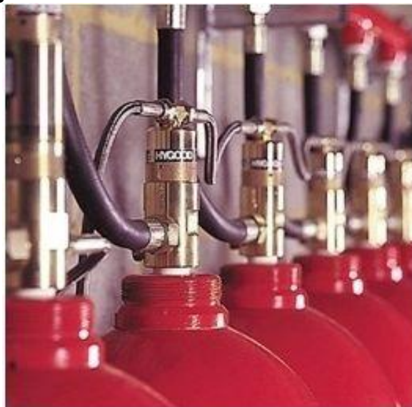
Figura 24: Sistema fixo de Dióxido de Carbono
