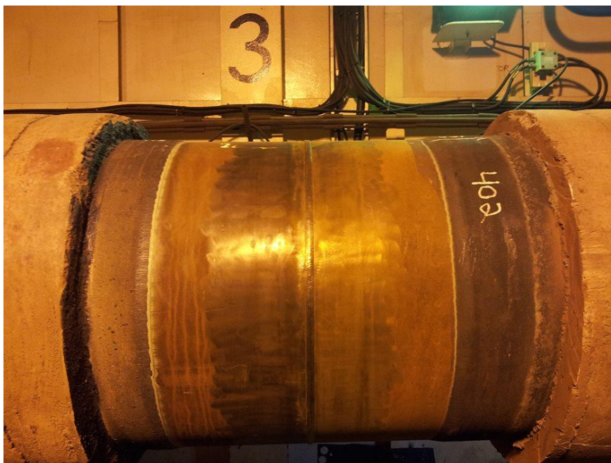
Figura 10 – Duto após todos os processos de solda
