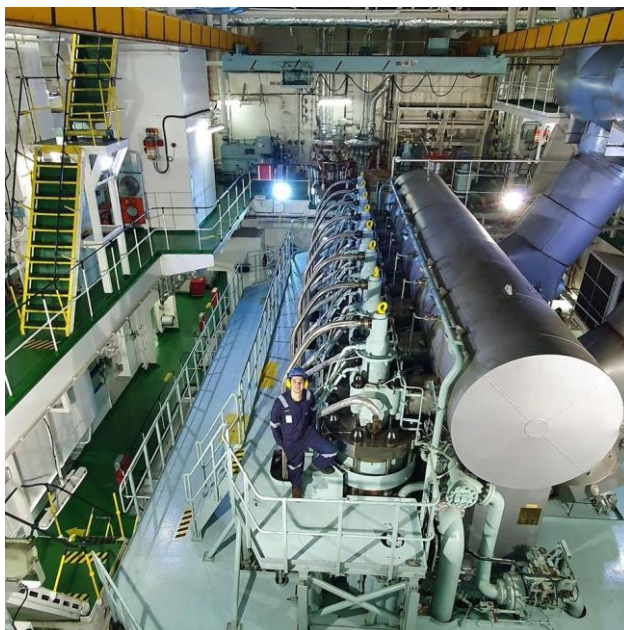
Figura 1: Praça de Máquinas
