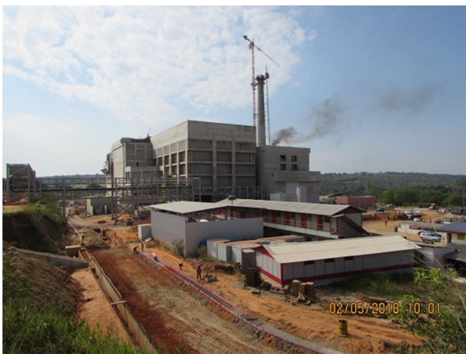
Figura 14 LABGENE em construção
