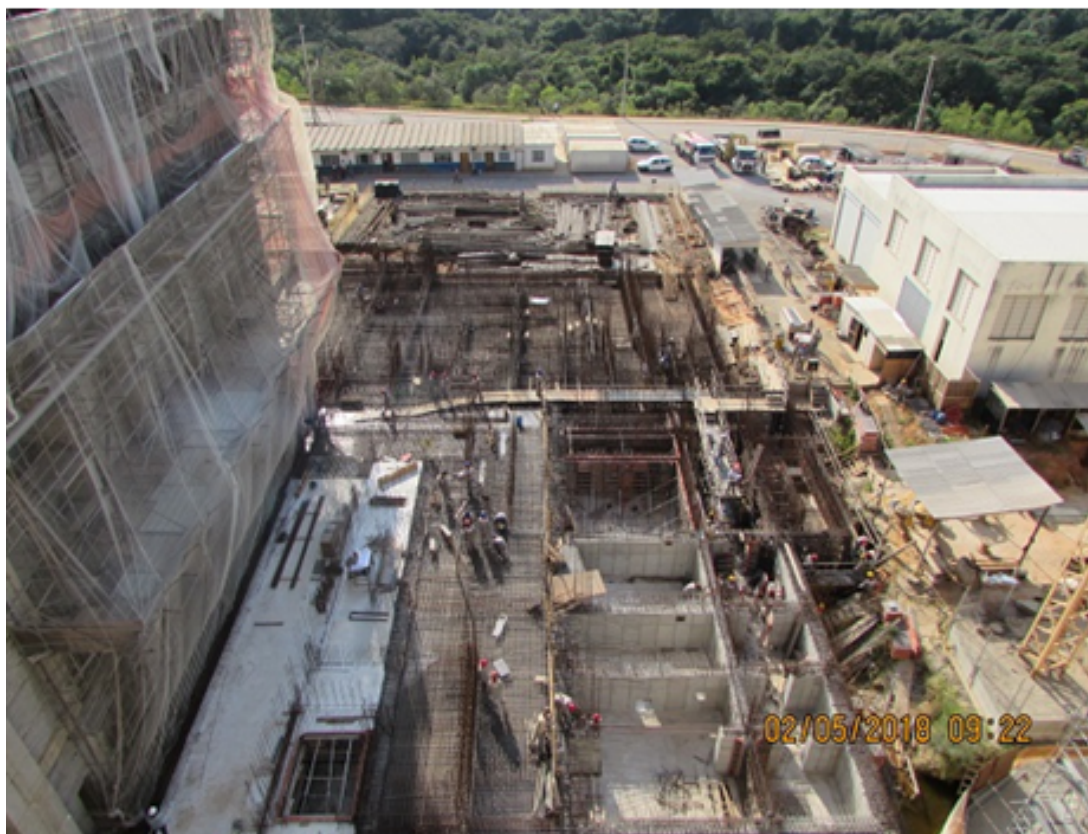
Figura 19 Prédio Auxiliar Controlado do LABGENE
