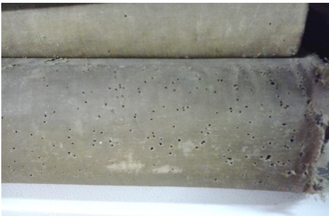
Figura 7: Observações Clínicas - Deterioração por agentes biológicos
