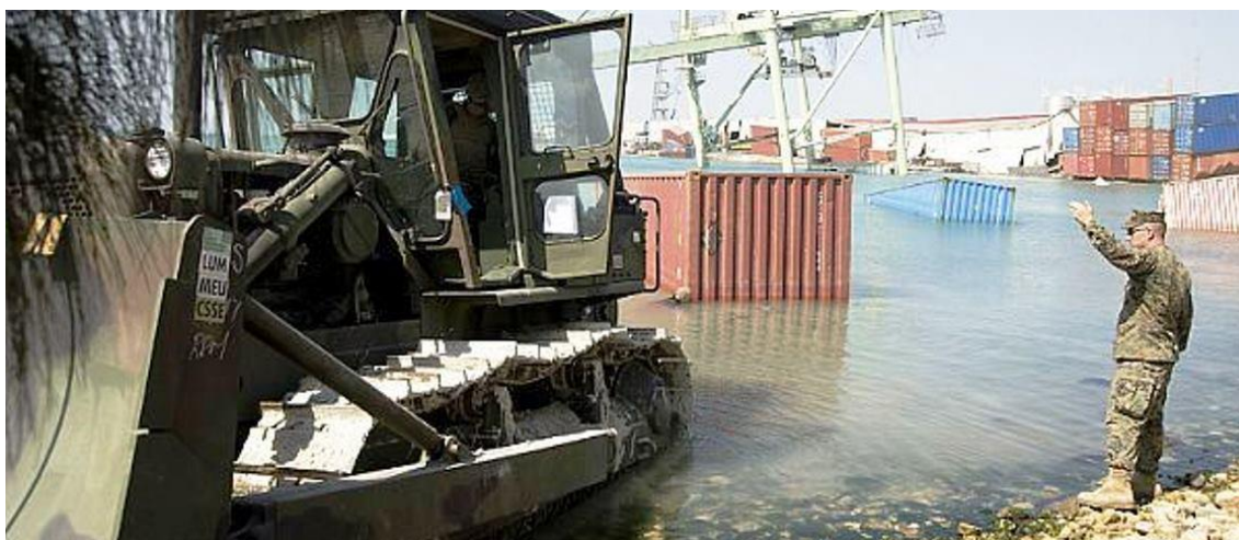
FIGURA 5 – Meios de engenharia no reparo do porto
