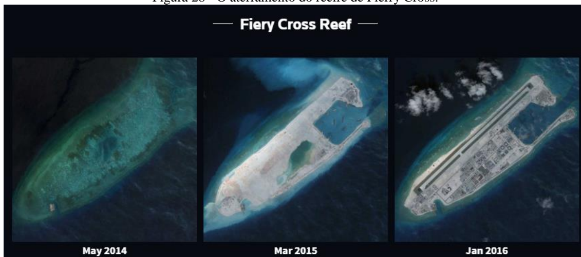
Figura 28 - O aterramento do recife de Fierry Cross.
