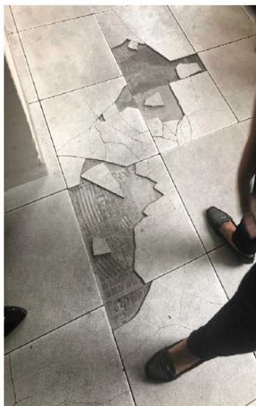
Figura 13 - Piso do corredor
