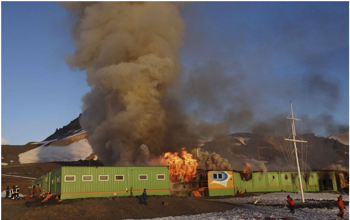
FIGURA 8 – O incêndio na EACF (25 fev. 2012). Fonte: G1, 2012b.
