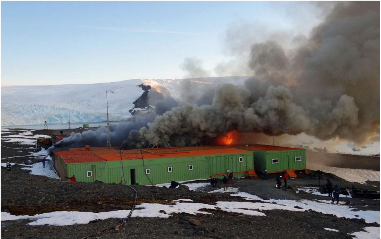
FIGURA 9 – O incêndio na EACF (25 fev. 2012). Fonte: G1, 2012b.
