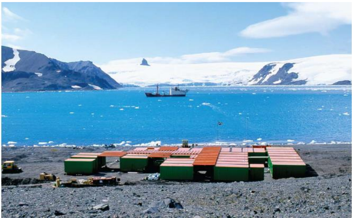
FIGURA 6 – A EACF em 1985, com o NApOc Barão de Teffé ao fundo. Fonte: SOUZA, 2008.
