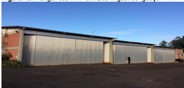
Figura 12: Hangar das ARP em São Miguel do Iguçu - PR
