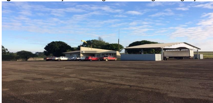
Figura 11: Instalações do hangar em São Miguel do Iguçu - PR
