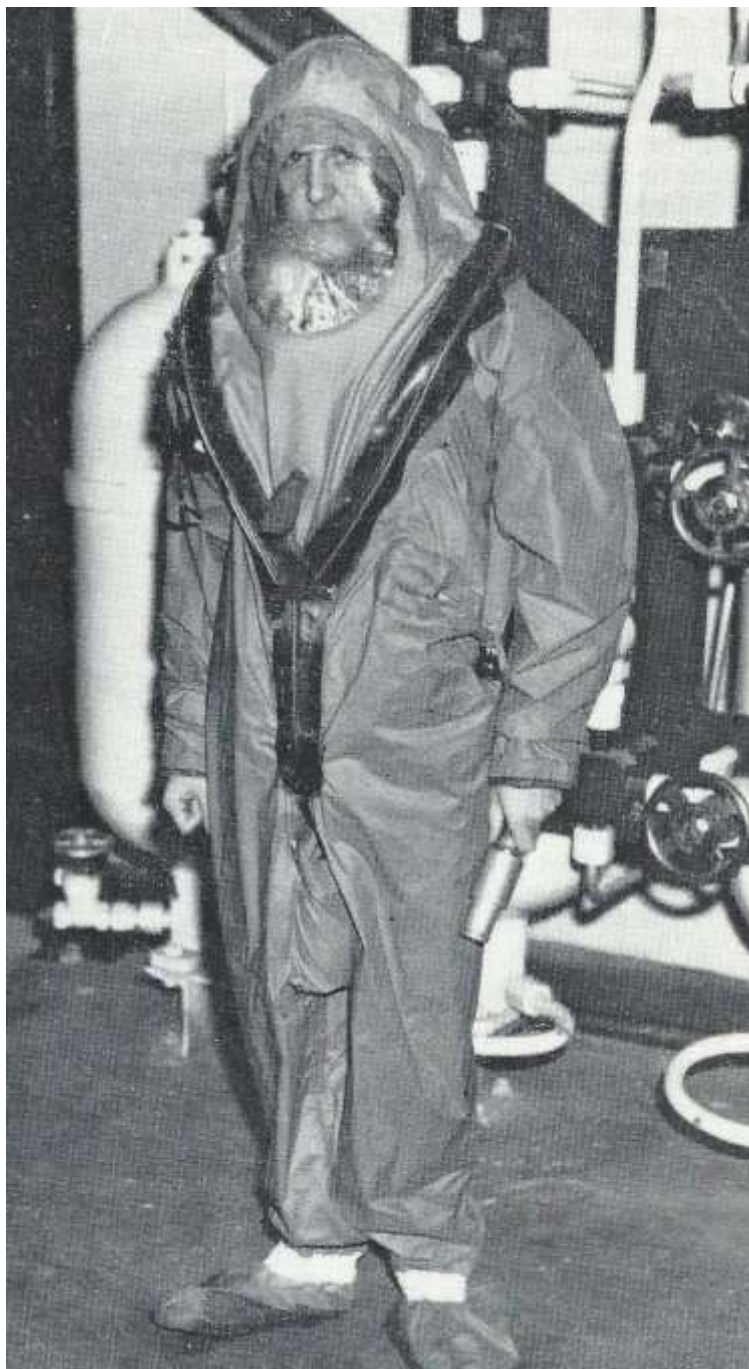
Figura 18 – Protótipo britânico para o Hood Inflation System utilizado no escape ou ascensão livre ( Free Ascent )
