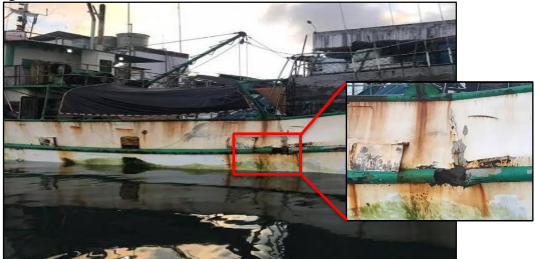
Figura 5 - Foto detalhada da lateral danificada do Barco Oceano Pesca 1
