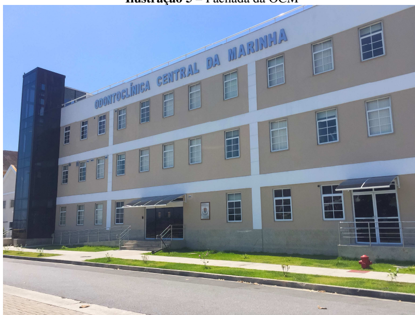
Ilustração 5 – Fachada da OCM
