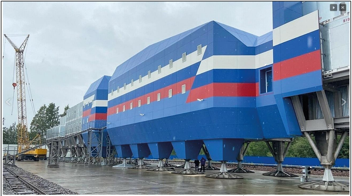
FIGURA 6 – Construção da nova estação antártica russa “Vostok”.
