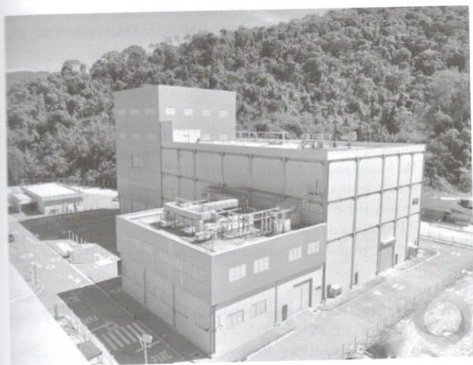
Figura 19 – Edifícios 2340 e 2380 do CMS-SUB (DEFESANET, 2021)
