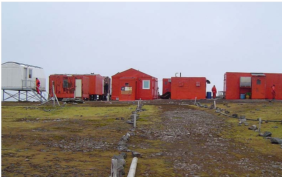
Figura 54 – Instalações da Base Científica Luis Risopatrón . Disponível em: < https://www.inach.cl/inach/?page_id=12700 >. Acesso em: 29 mai. 2023.
