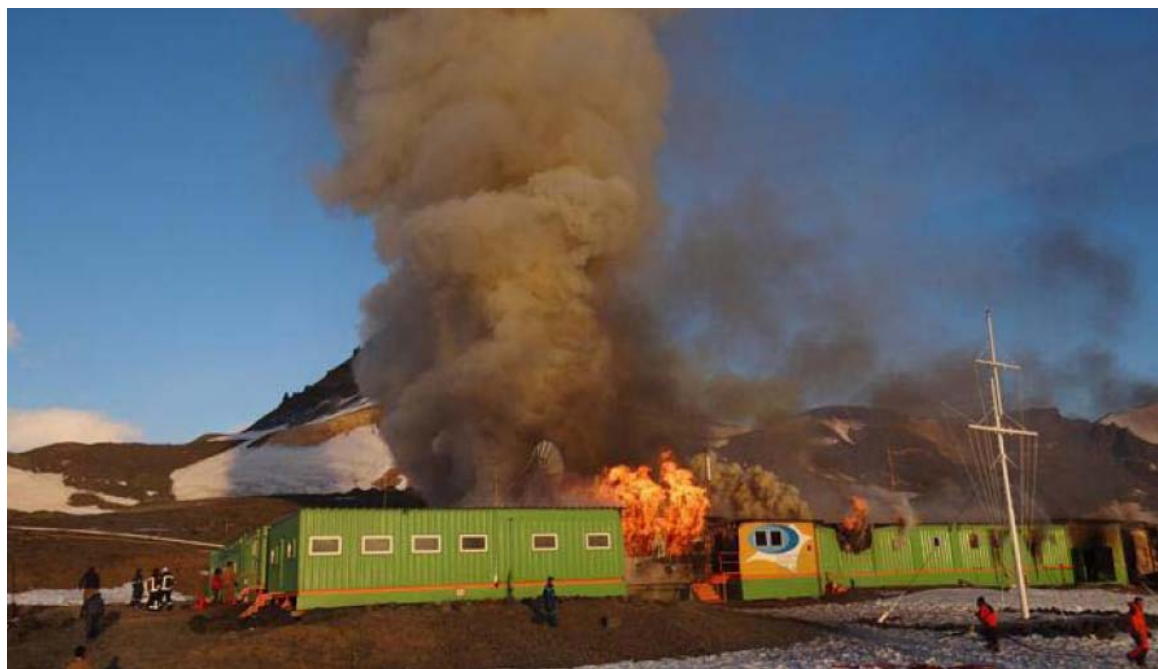
Figura 18 – Incêndio ocorrido em 2012 nas instalações da EACF. Disponível em: < https://www.senado.leg.br/comissoes/CMA/AP/AP20120228_Apresenta_MARINHA.pdf >. Acesso em: 01 abr. 2023.
