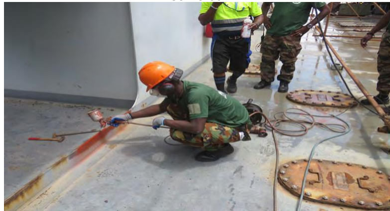
Figura 35 – Tratamento de chapas em Navio da Marinha do Cameroun
