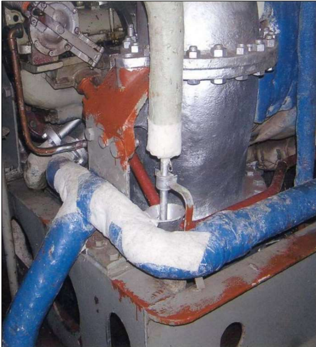
Figura 10 – Reparos efetuados no isolamento térmico de tubulação no ex-USS Oriskany Fonte: Laura S. Johnson – disponível em US-EPA/MARAD (2006)
