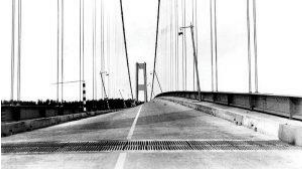
Figura 7: Fenômeno de ressonância ocorrendo na Ponte Tacoma Narrows em 1940.
