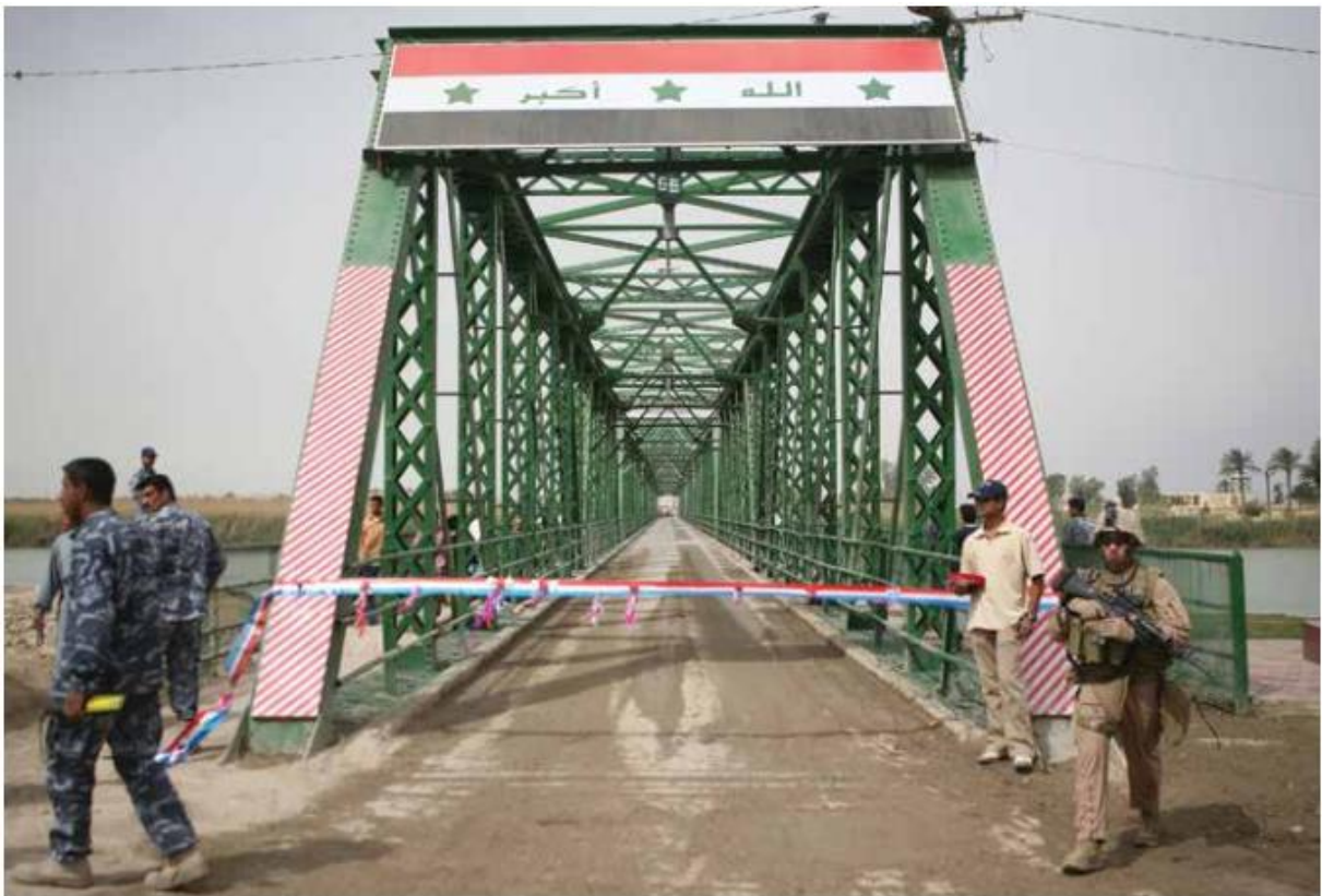
Figura 2 - Ponte sobre o rio Eufrates na cidade de Fallujah .
