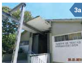
Figuras 3a e 3b (a) Fachada do prédio com detalhe para o sistema eletromecânico de posicionamento e b) Ponto de abertura do tanque de água doce para a realização de testes hidroacústicos
