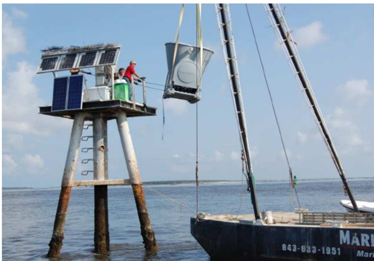
Figura 14 – Instalação do sensor SODAR.
