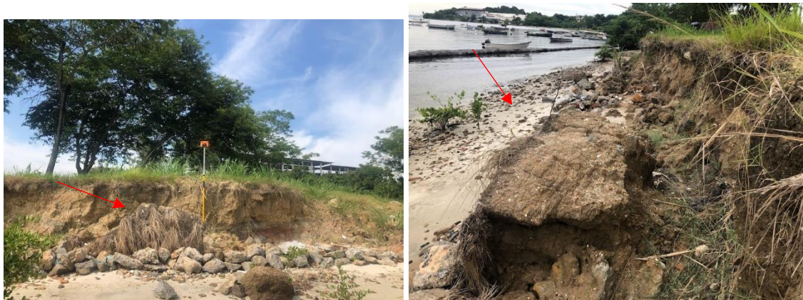
Figura 47 – Fotografias da encosta imediatamente a sudeste da rampa experimental, com destaque para o bloco de solo desagregado, visto por baixo (esquerda) e por cima (direita) – (Fonte: acervo pessoal, janeiro/2024).
