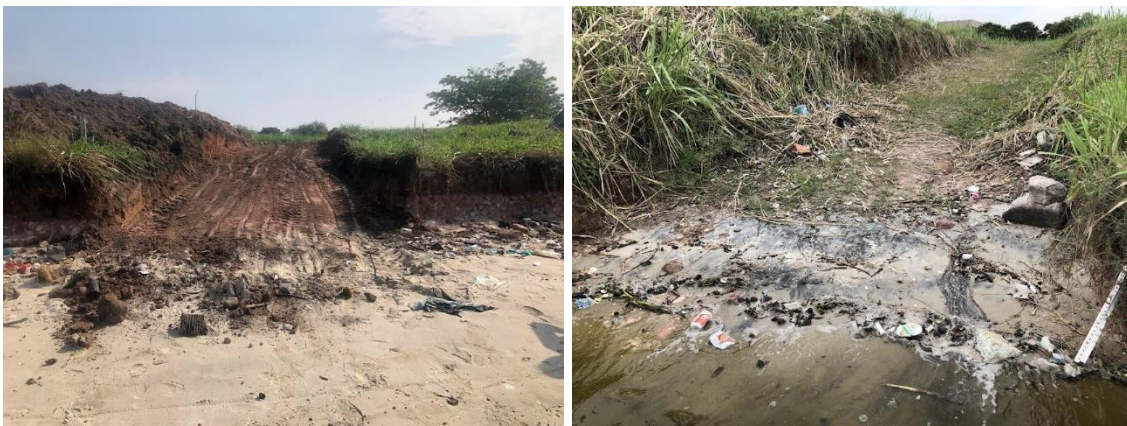
Figura 54 – Fotografias da rampa de controle recém executada (esquerda) e ao fim do monitoramento (direita)– (Fonte: acervo pessoal, outubro/2023 - esquerda e janeiro/2024 - direita).
