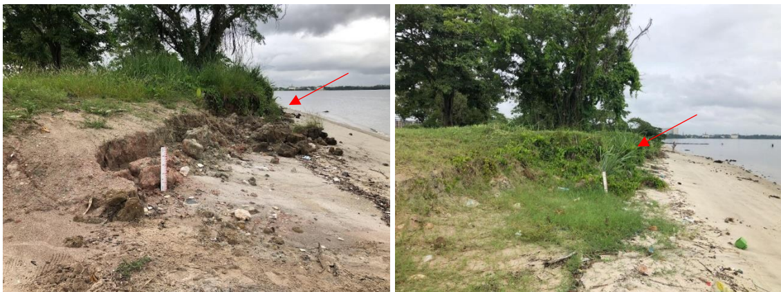
Figura 46 – Fotografia da encosta imediatamente a noroeste da rampa experimental, em diferentes datas, com destaque para o bloco de solo desagregado – (Fonte: acervo pessoal, outubro/2023 - esquerda e janeiro/2024 - direita).
