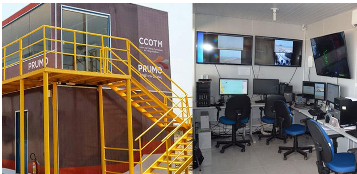
Figura 4 - Instalações do Centro VTS no Porto do Açú
